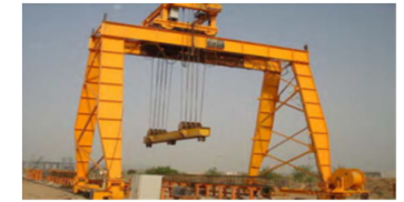
龍門架起重機 (Gantry Crane)
